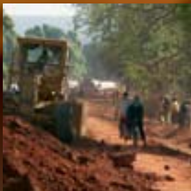
Catov motor greder pri delu, izravnavanju ceste, v Čadu.
