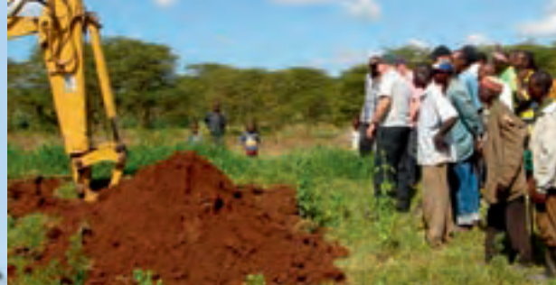
Del cevovoda je moralo skoraj 50 vaščanov izkopati in položiti ročno.
