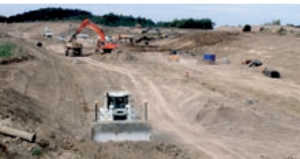
D6R z AccuGrade napreduje na 6 km dolgem odcepu avtomobilske ceste.
