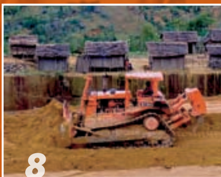
8 Začetek gradnje ceste.
