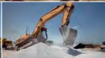
152. KM Hidraulični bager postavlja kamen u poziciju za razmještanje
