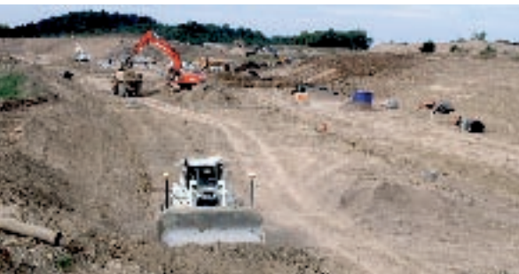
D6R s AccuGradeom radi na 6-km autocesti.
