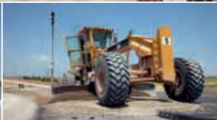
150. KILOMETAR Nivelisanje u toku uz pomoć grejdera sa 16H motorom
