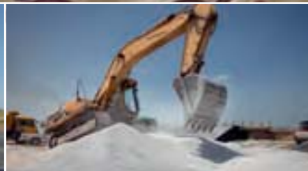
KM 152 Хидрауличниот багер придвижува камен во позиција подготвен за распределување
