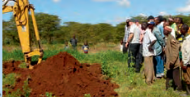
Sekcija cevovoda morala je da se iskopa rukom uz pomoć od oko 50 lokalnih stanovnika.
