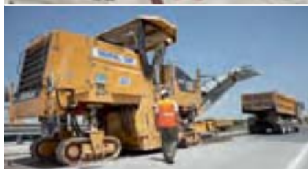
142. KM Freza za asfalt PM200 pri delu
