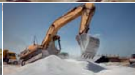
152. KM Hidravlični bager prestavlja kamenje in ga pripravlja za razporejanje
